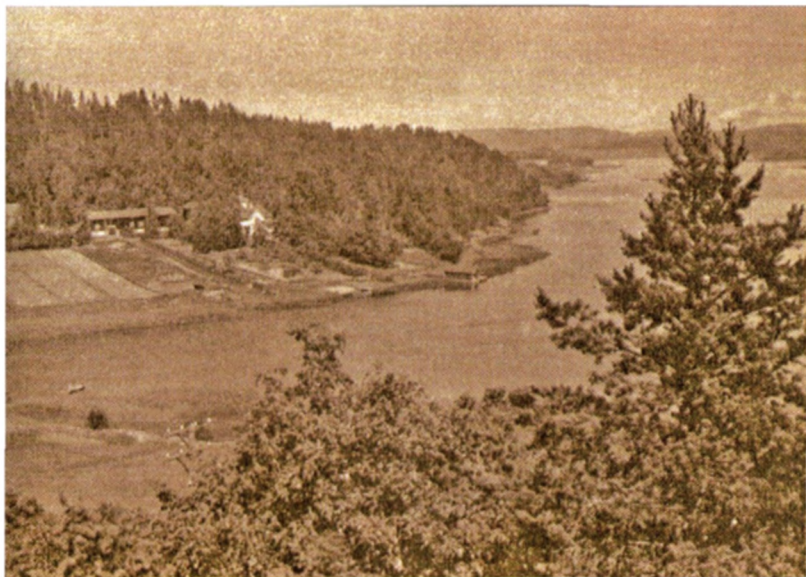
Залив Юхинлахти. Вид на имение Реландера
