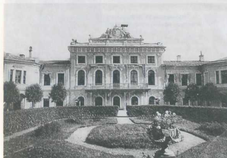
Путевой дворец Екатерины II. Центральная часть фасада
