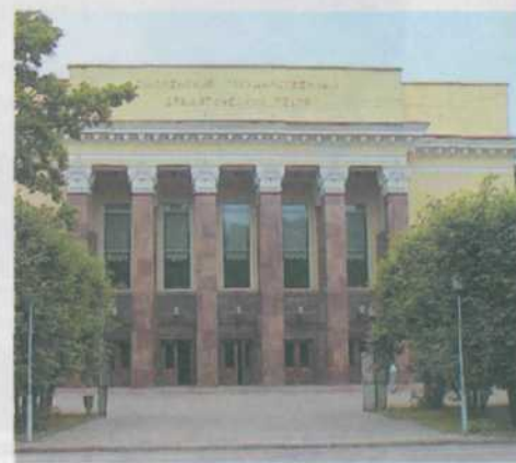
Драматический театр - здание 1930-х гг., восстановленное после 1945 г.
