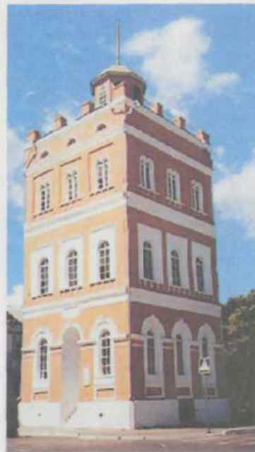
Водонапорная башня. Постройка XIX в.
