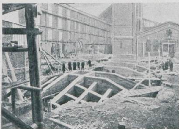
Рибристый желѣзобетонный фундаментъ „Понаби“ на Балтійскомъ Судостроительномъ заводѣ.
