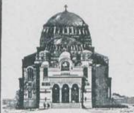
ПОТІЙСЬКИЙ КАТЕДРАЛЬНИЙ СОБОРЪ построенъ въ 10 мѣсяцевъ полностью изъ жел.-бетона.
